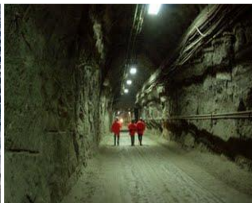
Túnel de la mina El Teniente.
